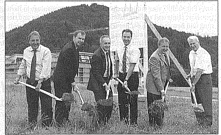
Horst Kary, Ingmar Roth, Urban Singler, Johann-Martin Rogg, Adolf Himmelsbach und Konrad Smiatek setzen im Gewerbegebiet Stollen II den ersten Spatenstich zur Erschließung der Gesamtfläche. Foto: Gabriele Zahn
